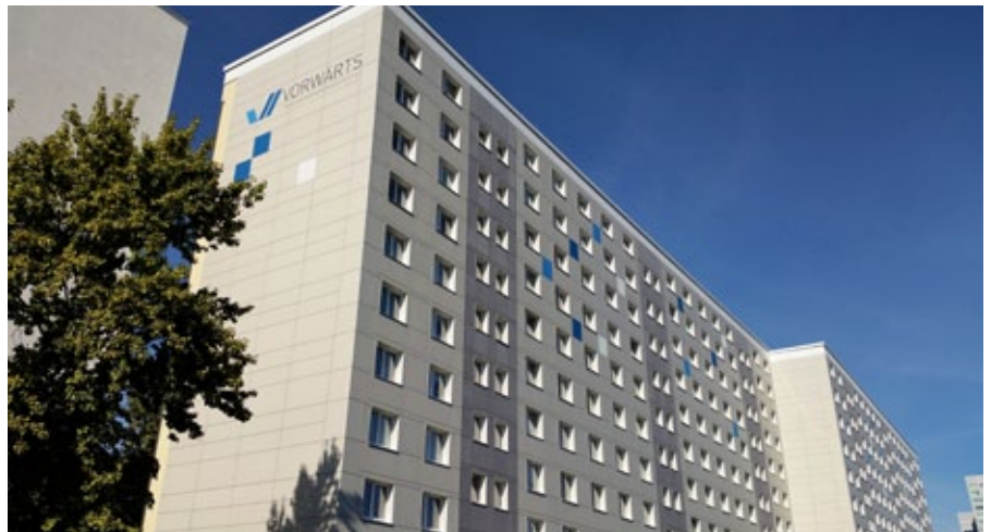
„Am Bärenschauenfenster“ straßenseitig
