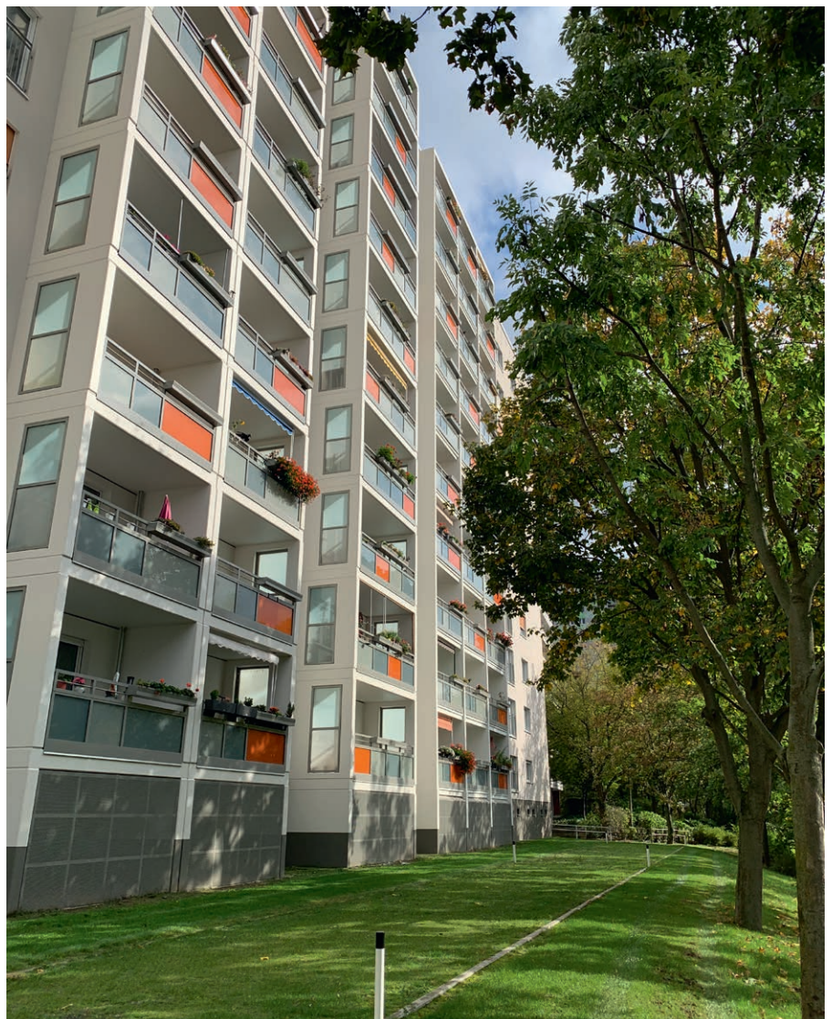
Nachträglich angebaute Balkone im Rosenfelder Ring
