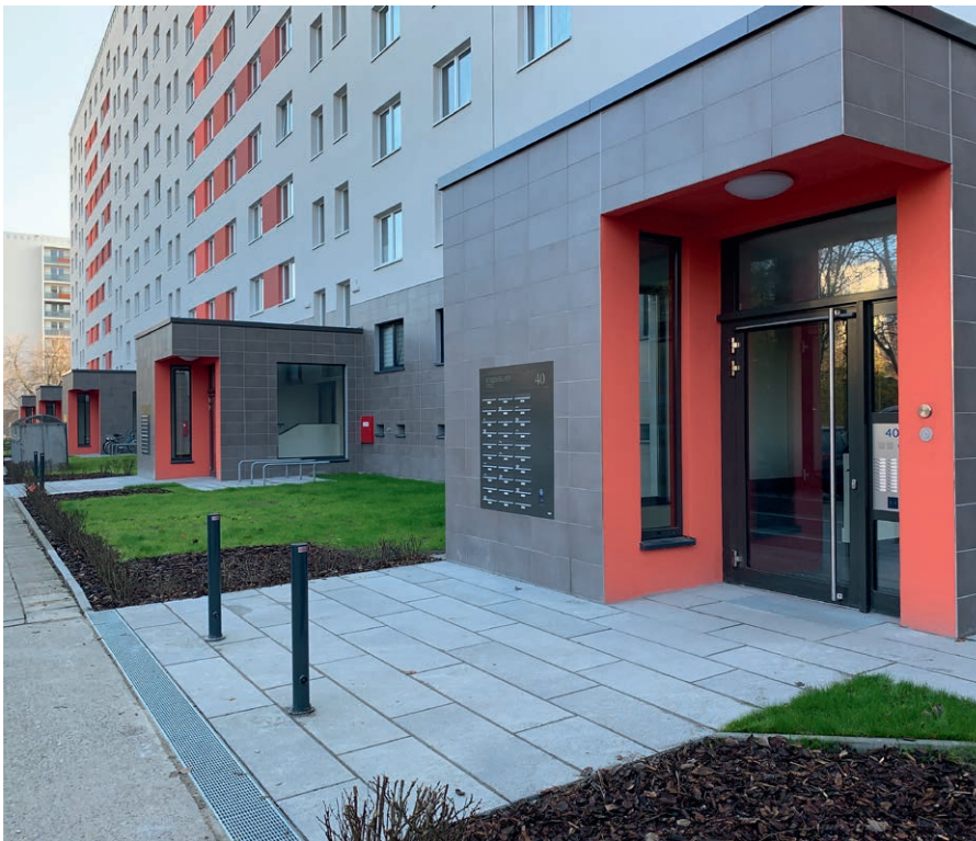
Die neuen barrierefreien Hauseingänge im Rosenfelder Ring
