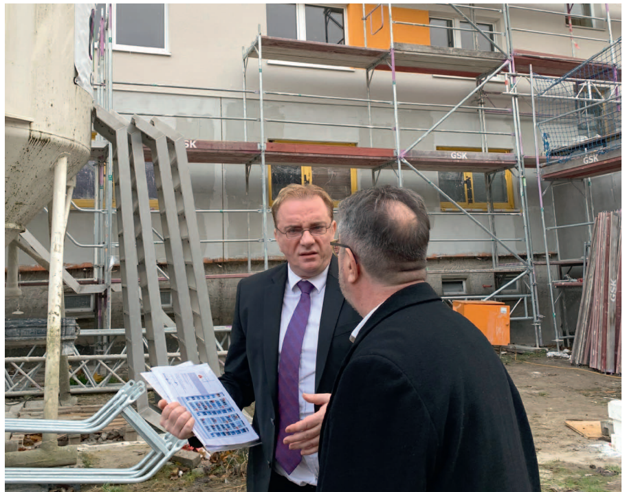
Mario Zelasny und Detlef Siedow auf der Baustelle im Rosenfelder Ring
