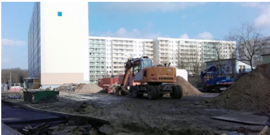
Aktuelle Situation auf der Baustelle
