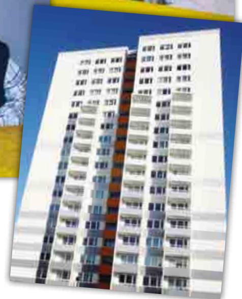
Dathepromenade 3 nach der Sanierung
